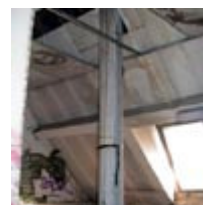
Tuyau de cheminée en amiante-ciment
