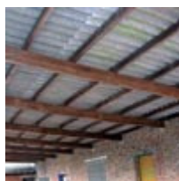
Plaques ondulées en amiante-ciment
