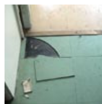
Colle noire et revêtement de sol
