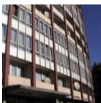
Allèges de fenêtres et revêtement de colonnes en glazal
