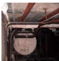
Calorifuge en fibroplâtre
